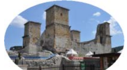
改修工事前の城
